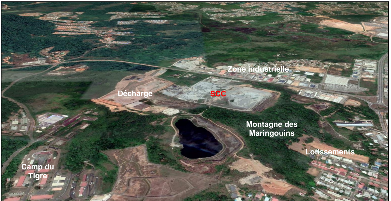
Figure 11 : Vue vers le Sud
